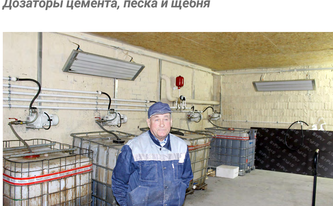
Отделение химических добавок БСЦ ООО «Завод ЖБИ-3». Можно использовать одновременно 6 видов химических добавок
