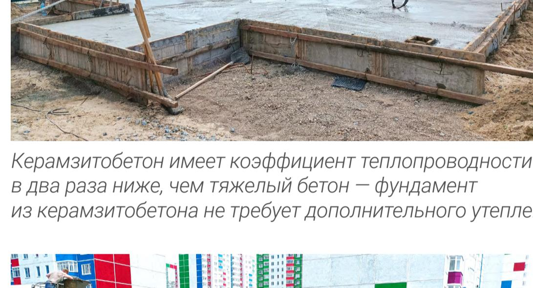
Керамзитобетон имеет коэффициент теплопроводности в два раза ниже, чем тяжелый бетон – фундамент из керамзитобетона не требует дополнительного утепления
