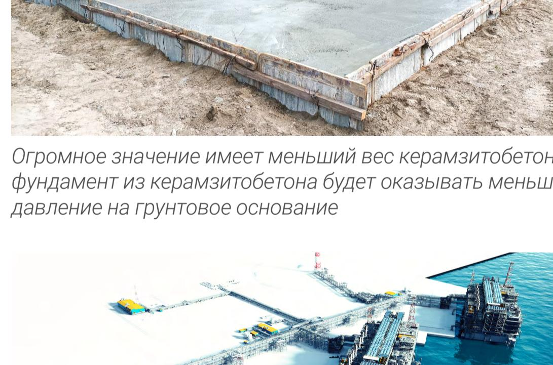
Огромное значение имеет меньший вес керамзитобетона – фундамент из керамзитобетона будет оказывать меньшее давление на грунтовое основание
