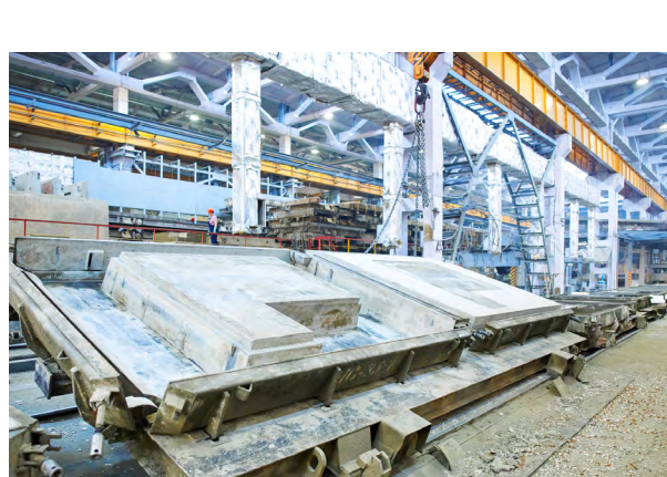
Процесс изготовления железобетонных изделий
