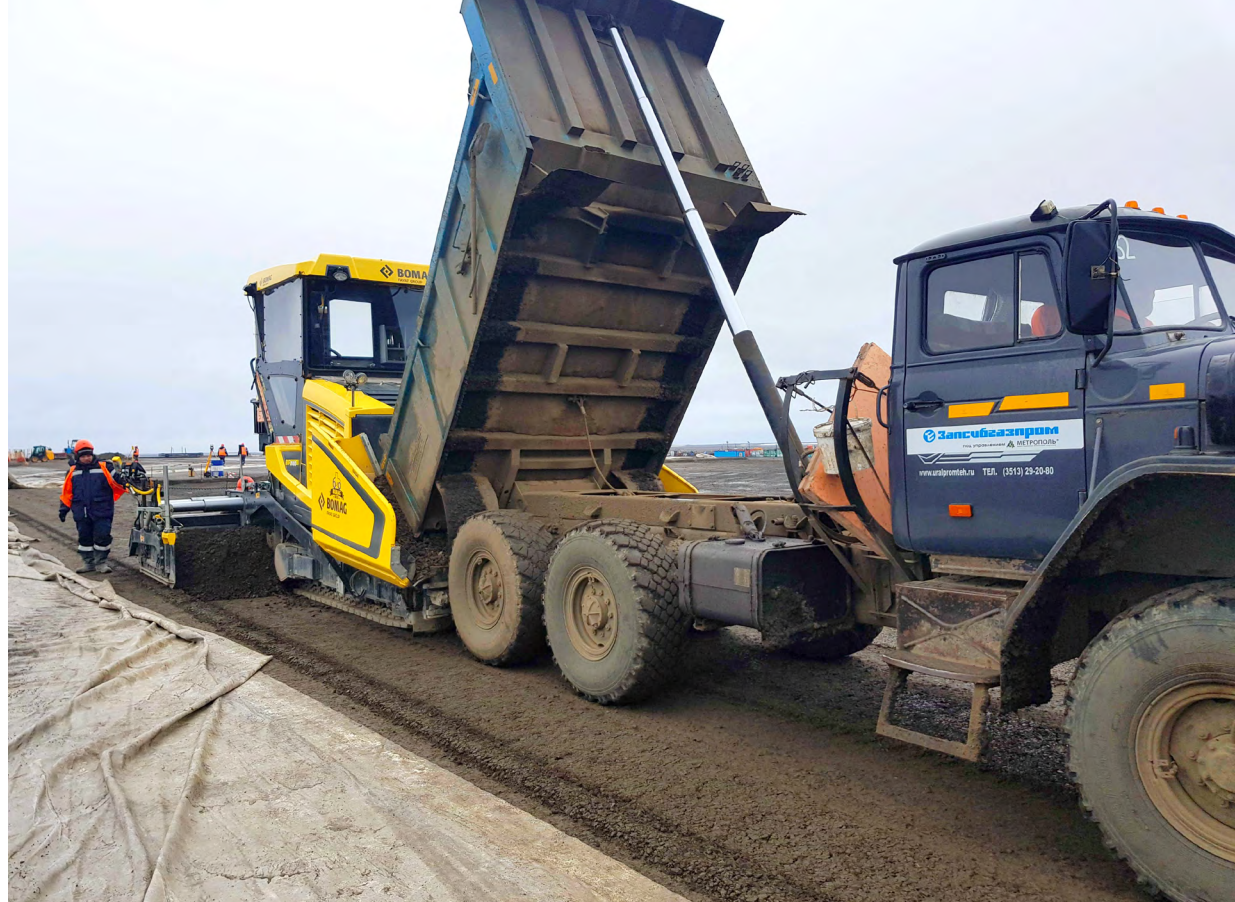
Устройство основания из полимерцементной смеси под искусственное покрытие из плит ПАГ-18
