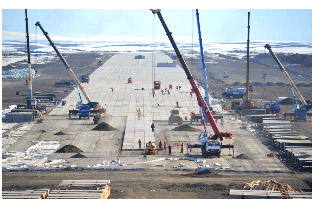
Строительство взлетно-посадочной полосы шириной 46 м, длиной 3,5 км
