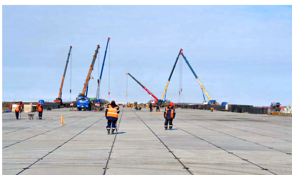
Заделка межплитных швов шнуром HotRod XL и битумной мастикой Брит Норд
