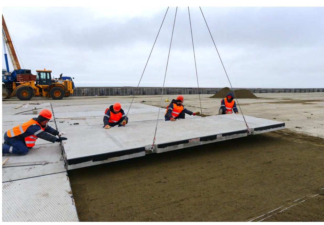
Укладка плит ПАГ-18 на пескоцементную смесь
