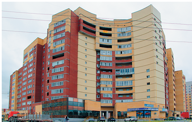
Микрорайон «Дружба» строится по ул. Дружбы – Щербакова, г.Тюмень
