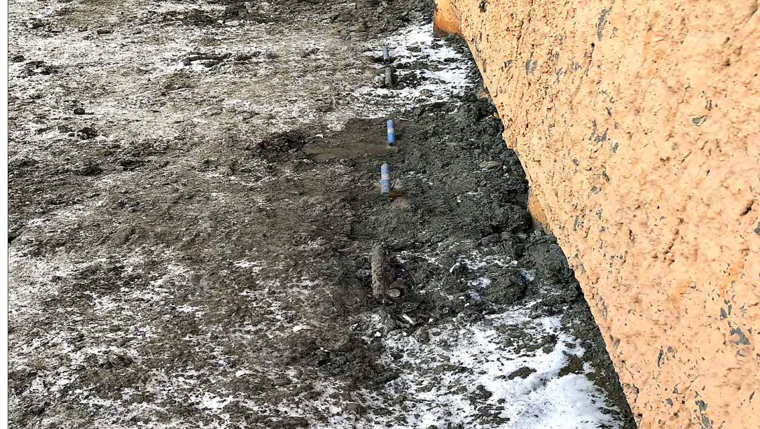
МОНТАЖ ВЕРТИКАЛЬНЫХ КОНДЕНСАТОРНЫХ БЛОКОВ СИСТЕМ «ВЕТ»
