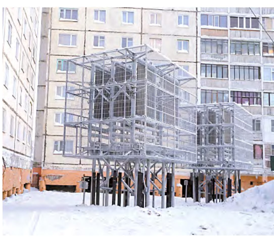
Углекислотные вертикальные системы «ВЕТ» для замораживания грунтов под фундаментами жилых зданий
