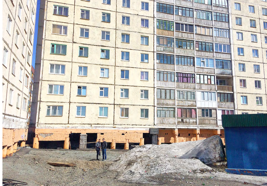
ВОССТАНОВЛЕНИЕ НЕСУЩЕЙ СПОСОБНОСТИ КОНСТРУКЦИИ ФУНДАМЕНТОВ ПРИ НАЛИЧИИ ВЫСОКОТЕМПЕРАТУРНЫХ ГРУНТОВ
