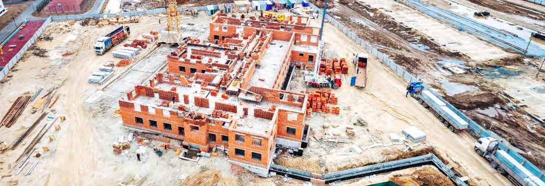
Строится детский сад на 320 мест
