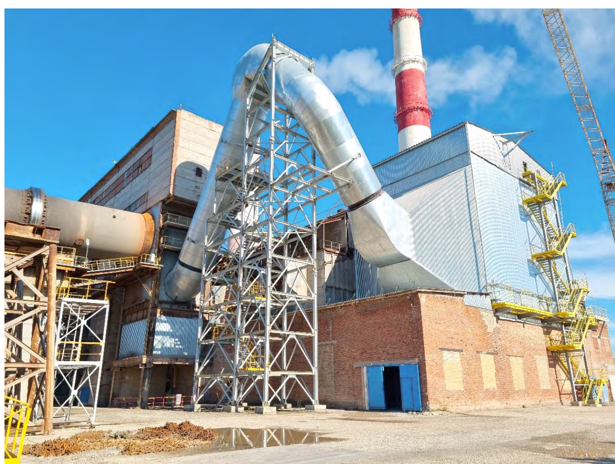
Электрофильтр вращающейся печи №4
